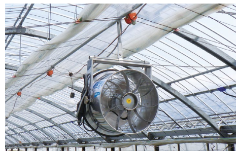
スライド式内張カーテン取付参考写真 Uボルト22.2φ用使用
