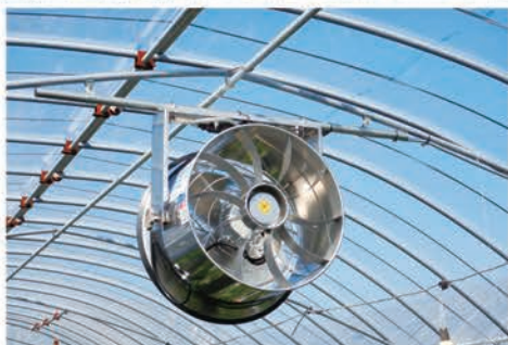
風来望取付例パイプ式内張カーテン取付参考写真 Uボルト22.2φ用使用
